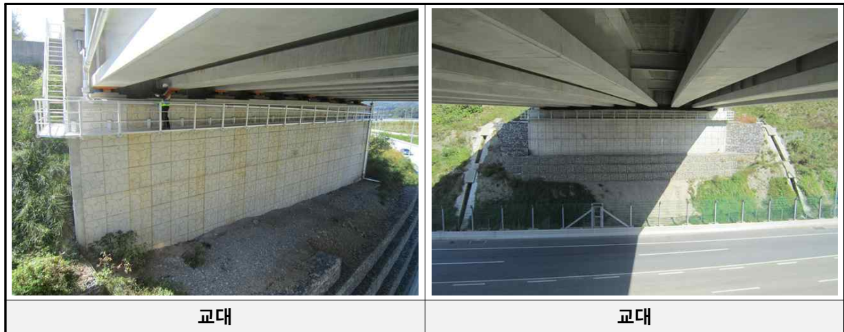
[교대 및 교각 전경]
